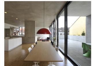
Das Gebäude ist vollständig in Sichtbetonweise errichtet, Außen- und Innenschale getrennt durch eine Kerndämmung. Eine besondere technisch-konstruktive Herausforderung stellt dabei die fugenlose Außenschale dar, welche durch die auftretenden Temperaturlasten enorme Zwängungen erfährt.
